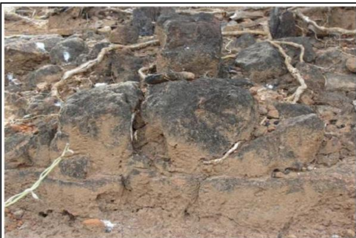
Base estrutural (alicerce) da residência do Sr. Domingos Alves de Santana
