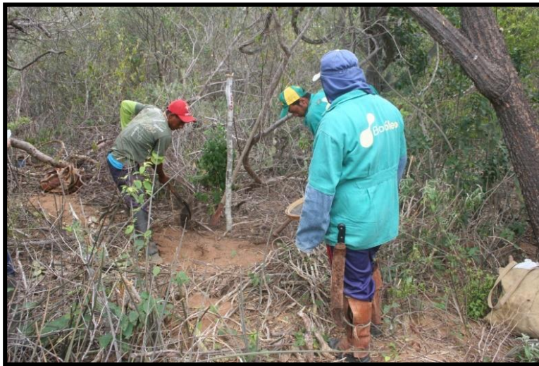
Figura 16: Abertura de poço teste. Setor I.
