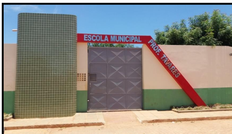
Figura 72: Município de Ourolândia. Fachada da Escola Municipal Prof. Tavares.
