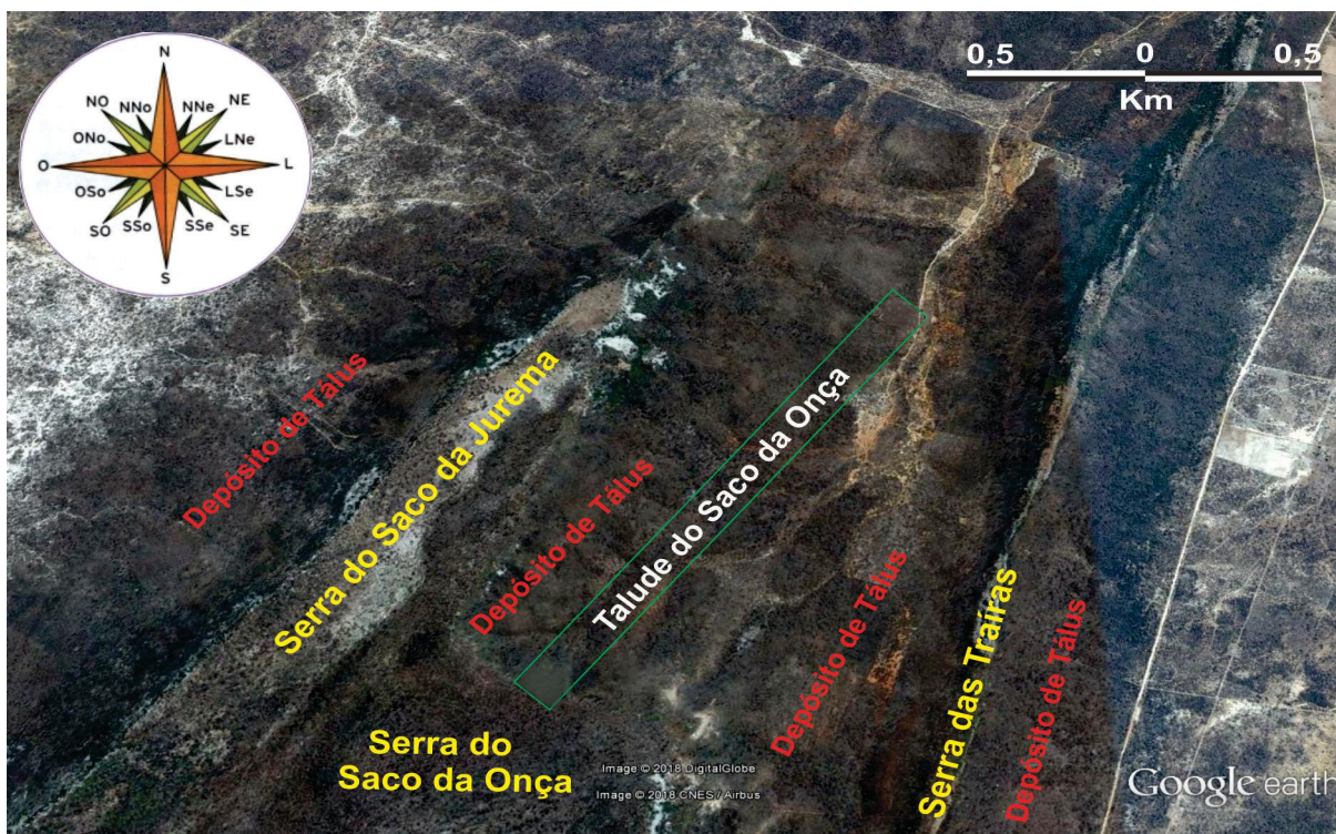
Figura 10 – Talude do Saco da Onça
