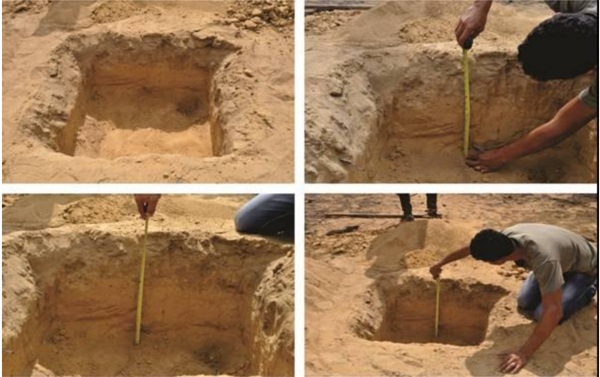
Figura 24 – Escavou-se até 0,5 metros de profundidade
