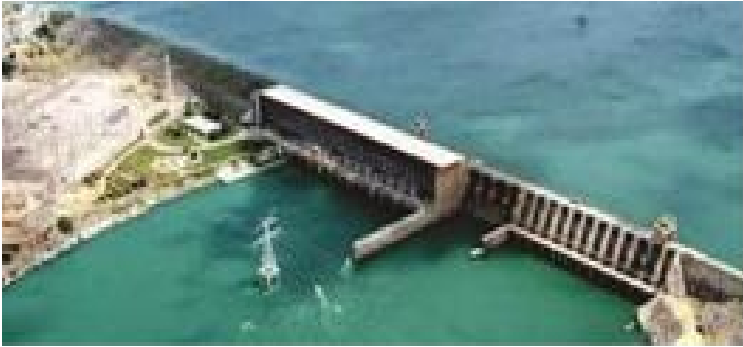
Figura 143 – Barragem de Sobradinho - BA
