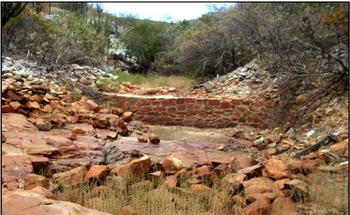
Figura 15 – Estrutura construída para armazenar água pluvial para apoio ao garimpo
