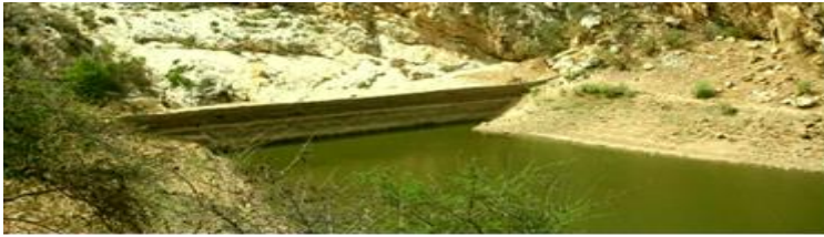
Figura 272 – Velha barragem, à montante do boqueirão
