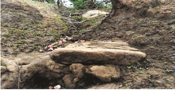
Figura 97 – Restos da barragem no leito do Rio São Lourenço
