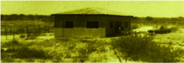
Figura 240 – Construção do primeiro pavilhão da EFAS
