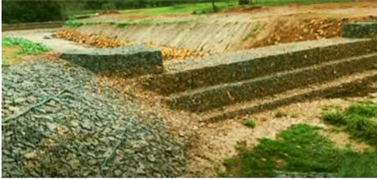
Figura 252 – Barragem de gabião, com soleira permeável
