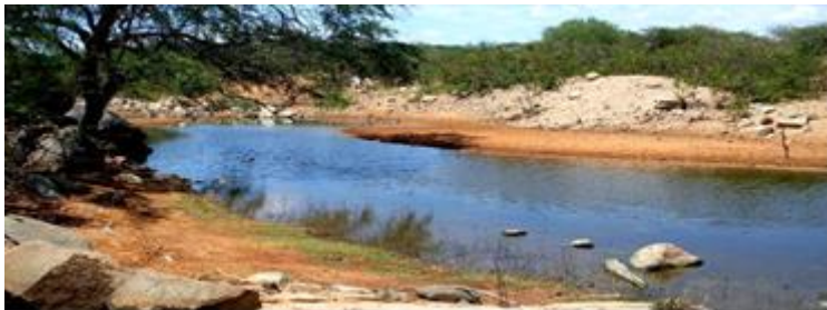
Figura 294 – Riacho a perenizar-se, à jusante da barragem
