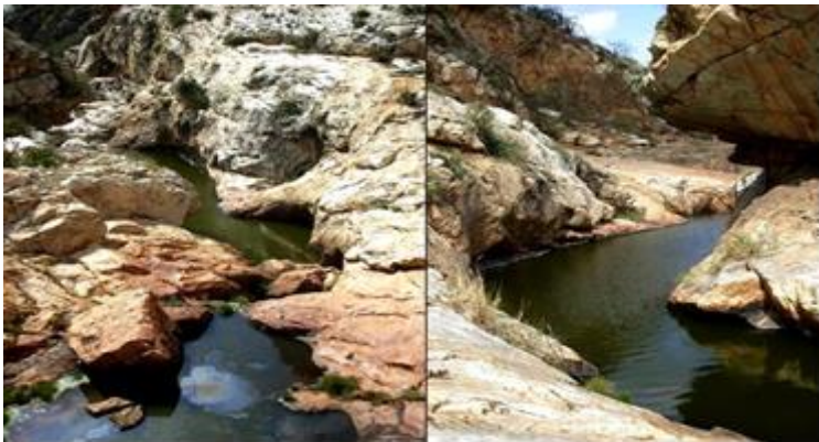
Figura 274 – Riacho a perenizar-se, à jusante da barragem
