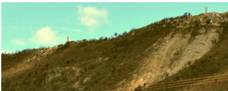
Figura 11 – Rejeitos derramados na encosta da Serra do Olho d'Água
