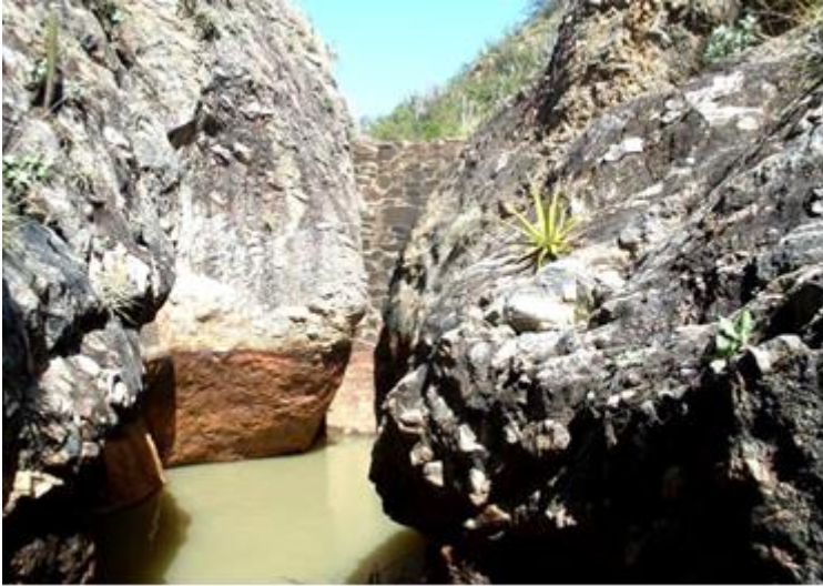
Figura 262 – Velha barragem a ampliar-se
