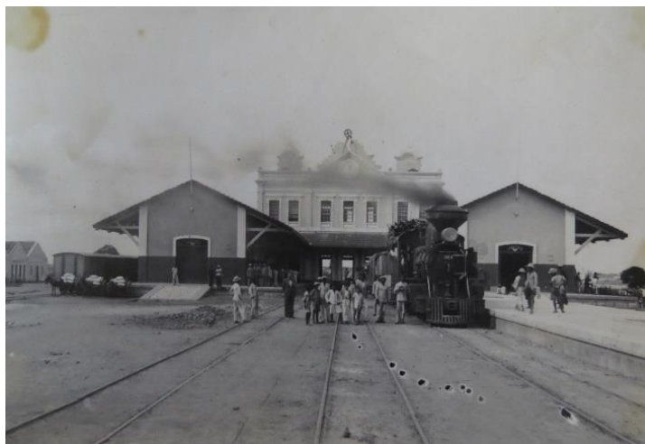
Figura 4 – Estação do São Francisco. Construída como destino final da Linha Férrea do Leste-Brasileiro, que ligava Salvador à Juazeiro
