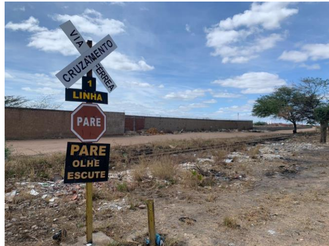
Figura 1 – Trecho da linha férrea no bairro Alto da Aliança, em Juazeiro
